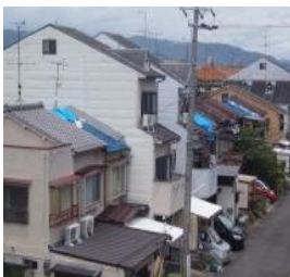
地震で屋根が被害に
