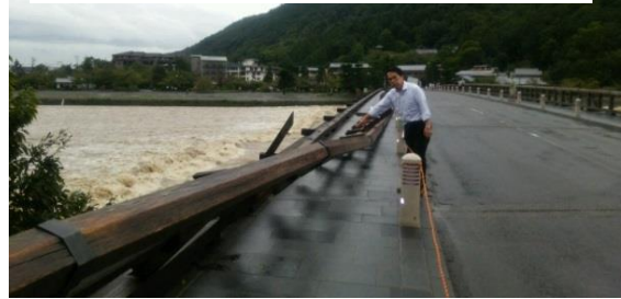
強風で、らん干が壊れた嵐山渡月橋を調査する西村市議
